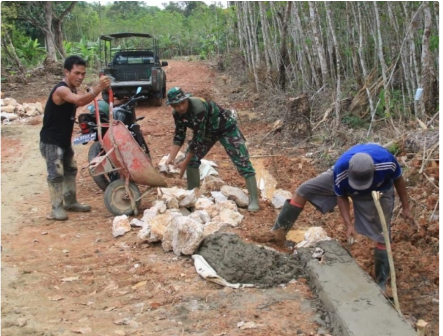
Pembuatan Badan Jalan Sepanjang 1020 meter Capai 45 Persen
